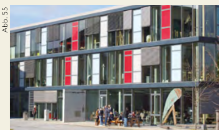
Auf dem Campus Emilie in Detmold befindet sich die Mensa im Erdgeschoss des Institutsgebäudes.
