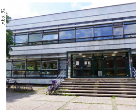
Das Gebäude der Mensa am FH-Standort Kurt-Schumacher-Straße – von 1970 bis 1975 befand sich hier die erste Bielefelder Uni-Mensa
